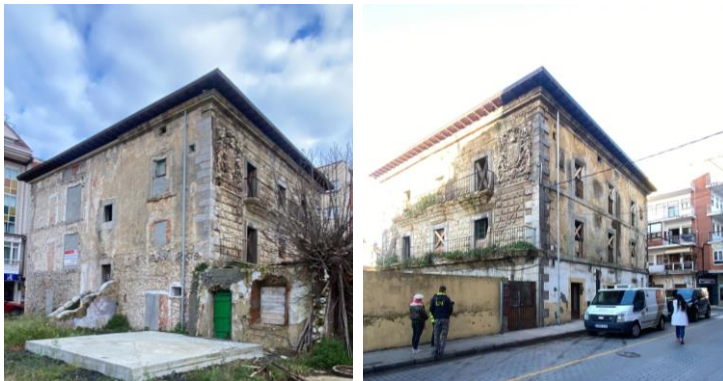
Vistas desde el sudoeste y sudeste, tras los derribos y la reconstrucción de la cubierta
