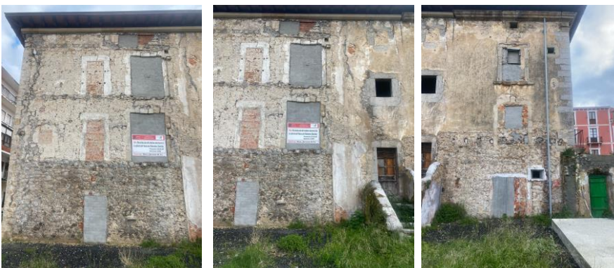
Vistas parciales fachada oeste
