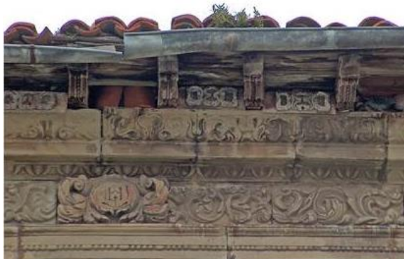
Detalles de la fachada principal, los almohadillados, el escudo y la cornisa, previa a la reconstrucción
