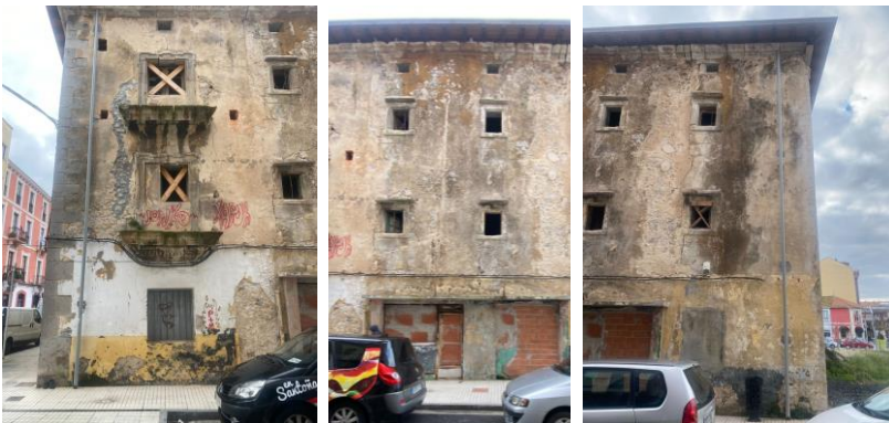
Vistas parciales fachada norte
