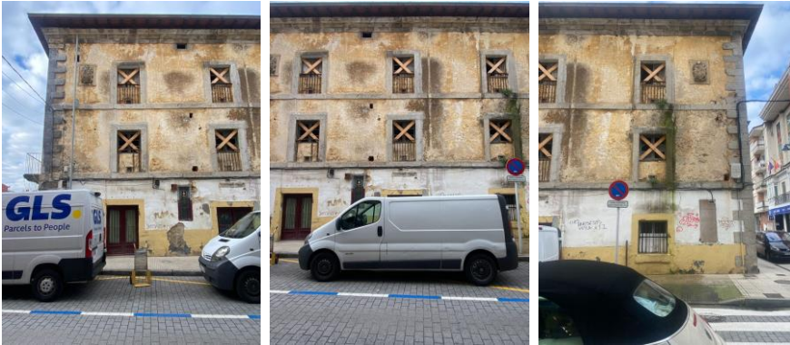
Vistas parciales de la fachada este
