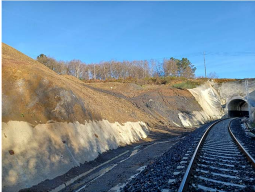
Fotografía toma en el P.K. 381+080 hacia Lugo
