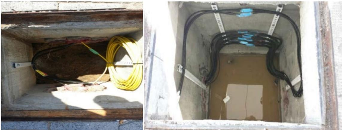
En todo el recorrido y en cada acceso registrable, el cable debe quedar fijo mediante bridas u otras sujeciones.
