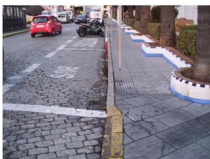
La calle **Transversal a calle Enrique Villegas** hacia calle San Diego tiene un acerado lateral de 1,65 de anchura y una calzada de 8,75 m de anchura media que se encuentra acabada con pavimento asfáltido. La accesibilidad desde el Paseo de la Ribera hasta el Paseo Fluvial de contorno de la Dársena se encuentra interrumpida por las alturas de los bordillos y por un paso de peatones no accesible en la calle Villareal santo Antonio.
