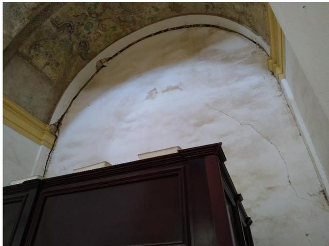
Fotografía donde se observa una de las grietas parabólicas.
