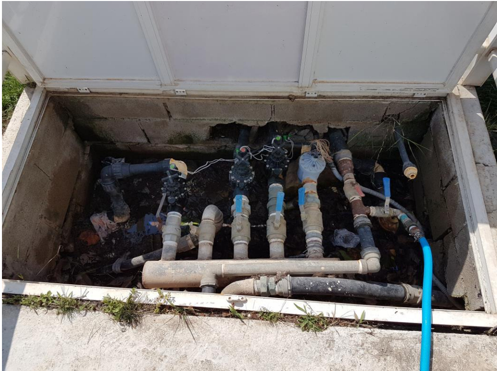
6. Instalación existente de sistema de riego, objeto de actuación
