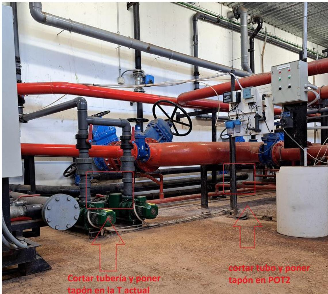
*Figura 5. Disposición del colector que une del POT1 y el POT2*
