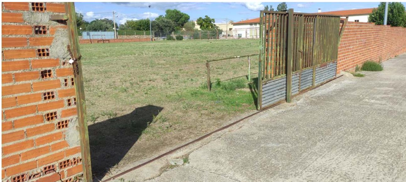
Las obras definidas en esta Memoria comprenden en el apartado de **reparar el muro perimetral de ladrillo existente, muy especialmente en la zona agrietada y debilitada sobre la zona del colegio público Luís Casado, dado que bajo el desnivel existente al otro lado del muro perimetral existen zonas de juegos del colegio, a su salida, pudiéndose causar graves daños personales en el caso de desprendimientos del muro.**
