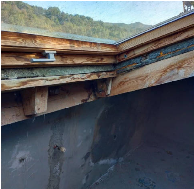
Figura 29. Detalle de tragaluz en bajocubierta. Se observa detalle del aislamiento del tejado y llave de calefacción
