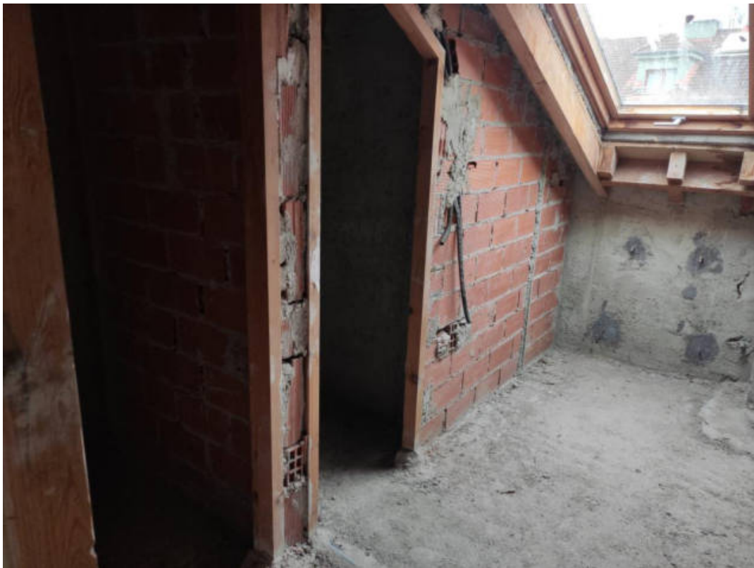
Figura 33. Espacio para baños en el bajocubierta
