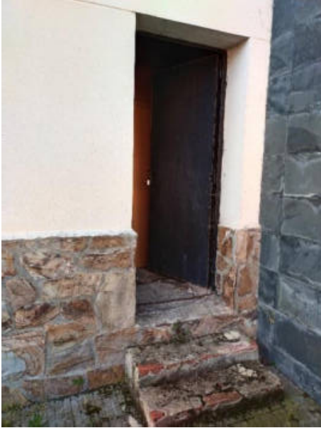
Figura 21. Entrada a la primera planta del edificio
