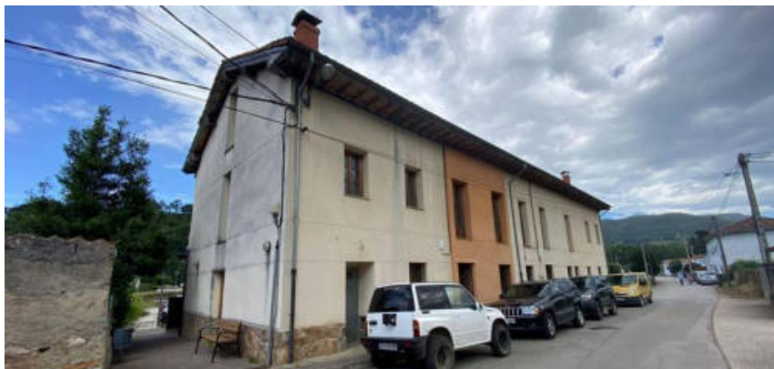
Figura 7. Ubicación. Vista desde la calle (caras Sur y Oeste del edificio)
