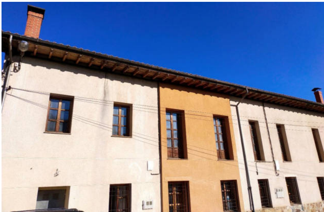
Figura 20. Detalle de ventanas en la fachada sur
