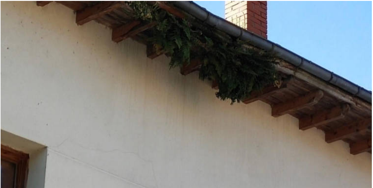
Figura 17. Gotera en alerón
