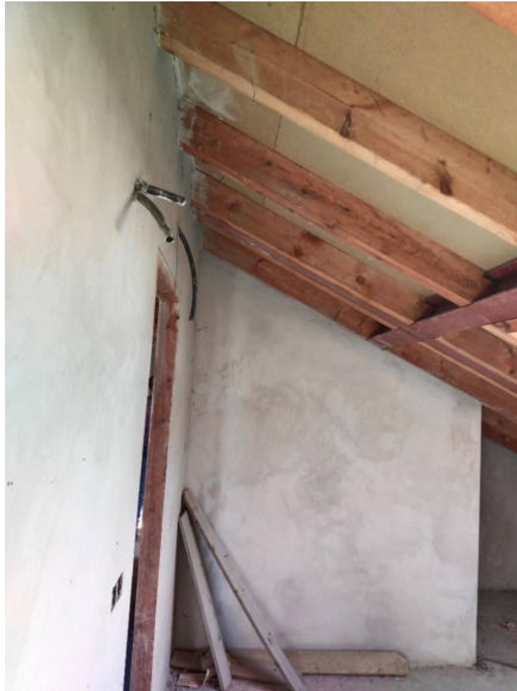
Figura 34. Detalle de habitación en bajocubierta. Se observan los tubos para cableado eléctrico, aunque sin éste incluido
