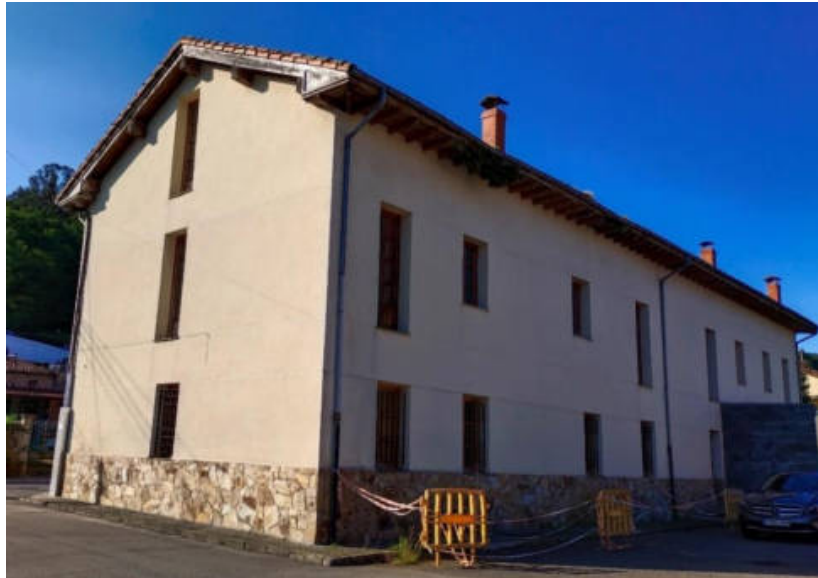
Figura 6. Ubicación. Vista desde la calle (caras Norte (entrada principal) y Este del edificio)
