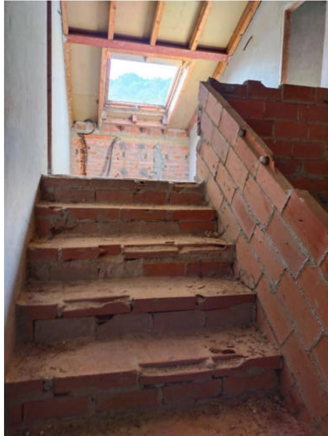
Figura 28. Escalera interior de acceso al bajocubierta
