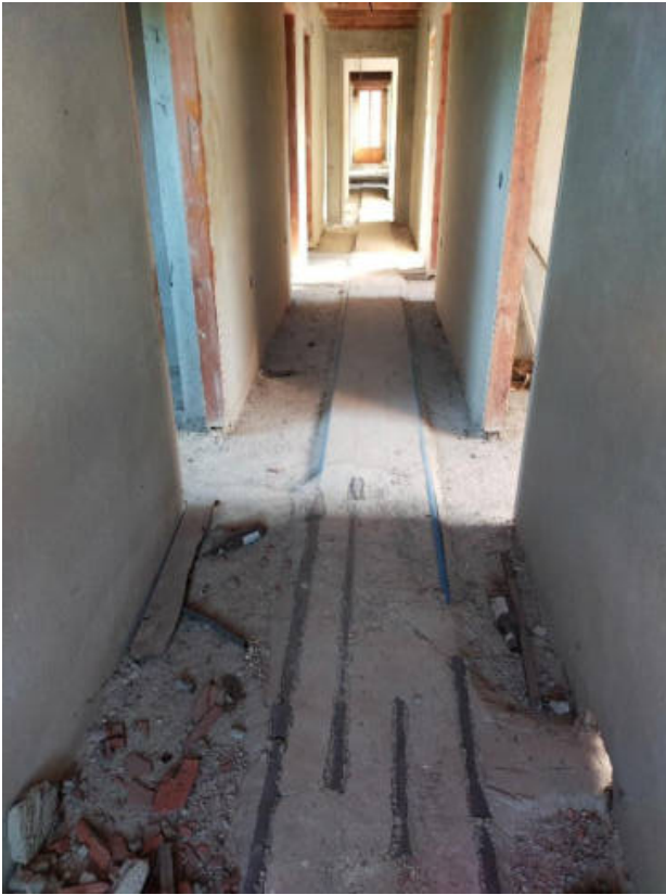
Figura 23. Pasillo central de la primera planta
