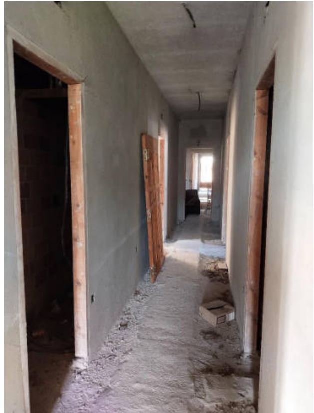
Figura 24. Pasillo central del bajocubierto
