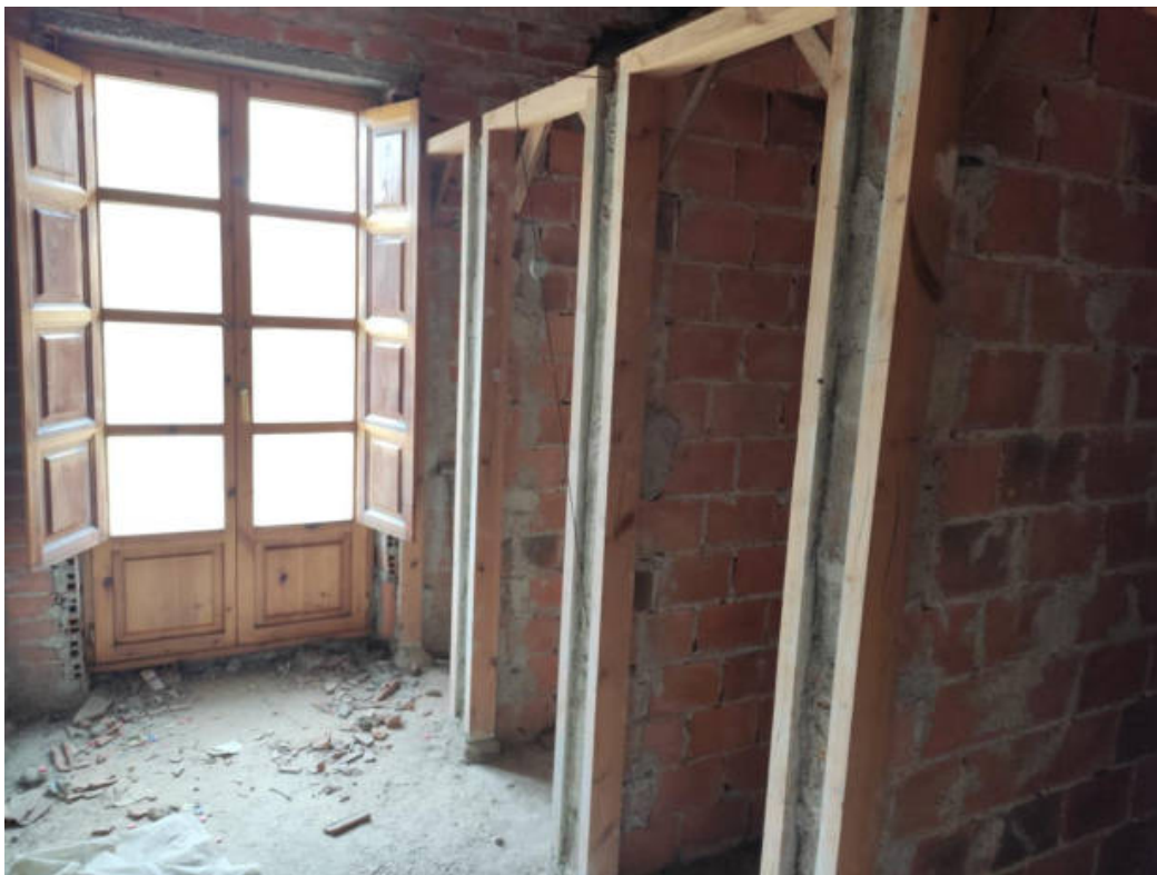
Figura 31. Espacio habilitado para sanitarios
