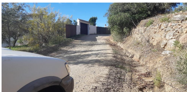
Foto 4. Zona de actuación con fuerte pendiente, curvas y problemas de drenaje de agua. Actuación en cunetas.
