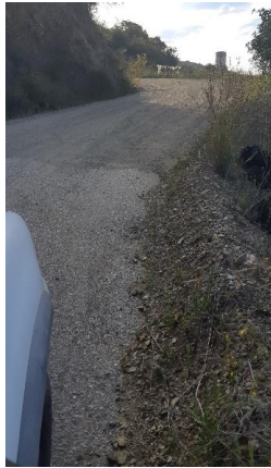
Foto 1. Zona de actuación con fuerte pendiente y curvas.
