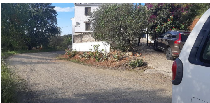
Foto 5. Zona de actuación con fuerte pendiente, curvas y problemas de drenaje de agua.
