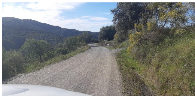
Foto 3. Zona de actuación con problemas de drenaje de aguas.
