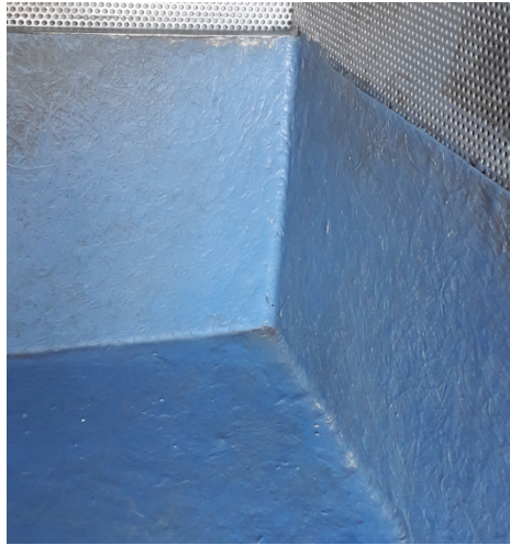
Figura 3. Fondo y laterales fabricados en fibra de vidrio o similar.
