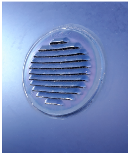
Figura 4. Rejilla de ventilación.
