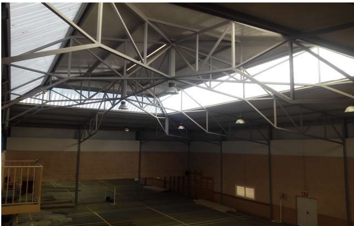
Vista general Gimnasio desde el interior (se pueden ver los seis focos en el techo)
