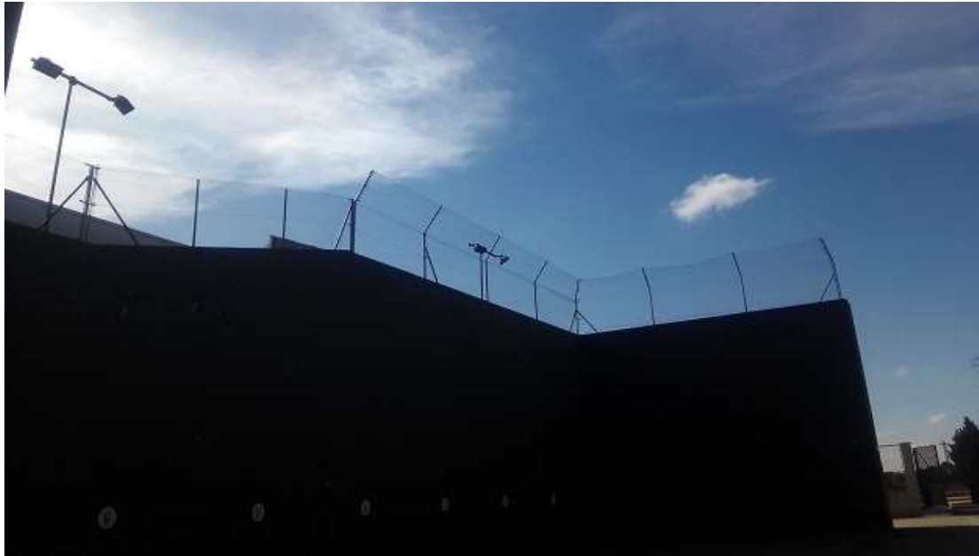
Vista general Pista Frontón donde se aprecian las dos torres de dos focos
