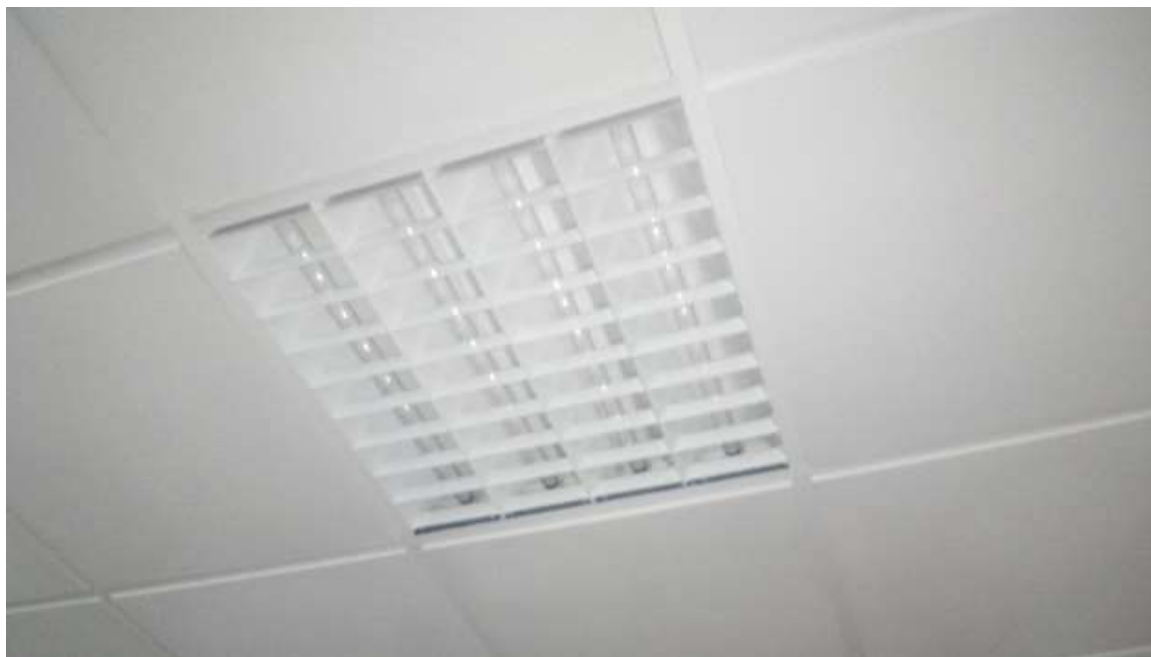
Detalle de la pantalla del vestuario del árbitro, donde se observan los 4 tubos fluorescentes
