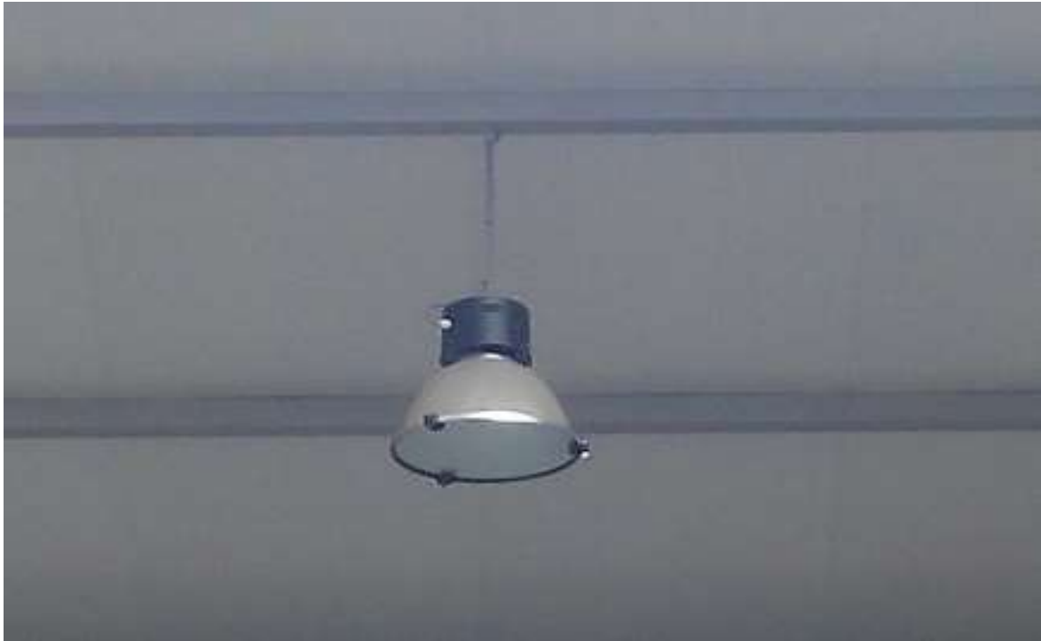
Detalle Foco techo Gimnasio
