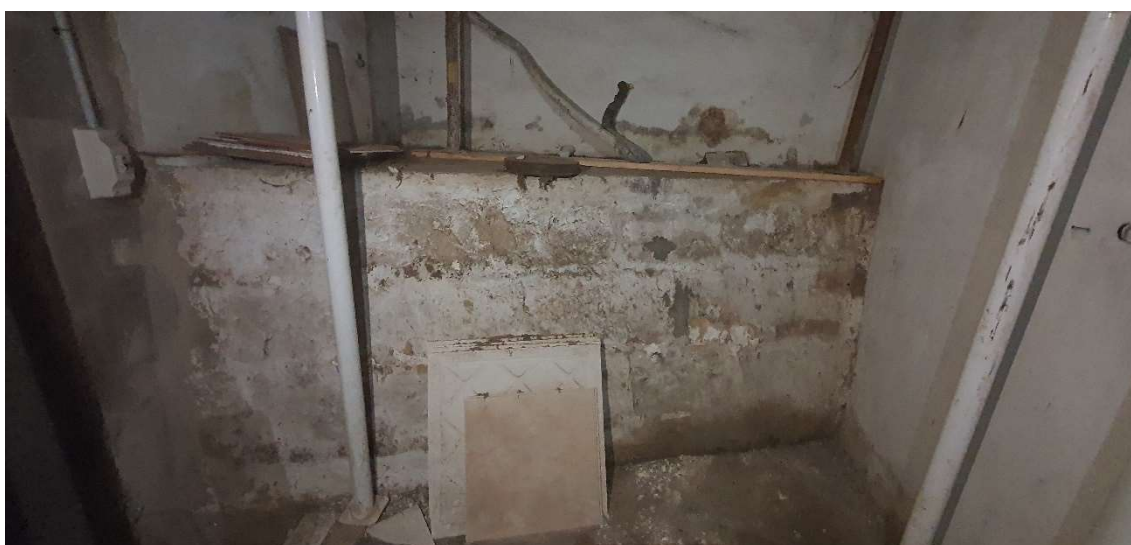
Tram de murada al soterrani
