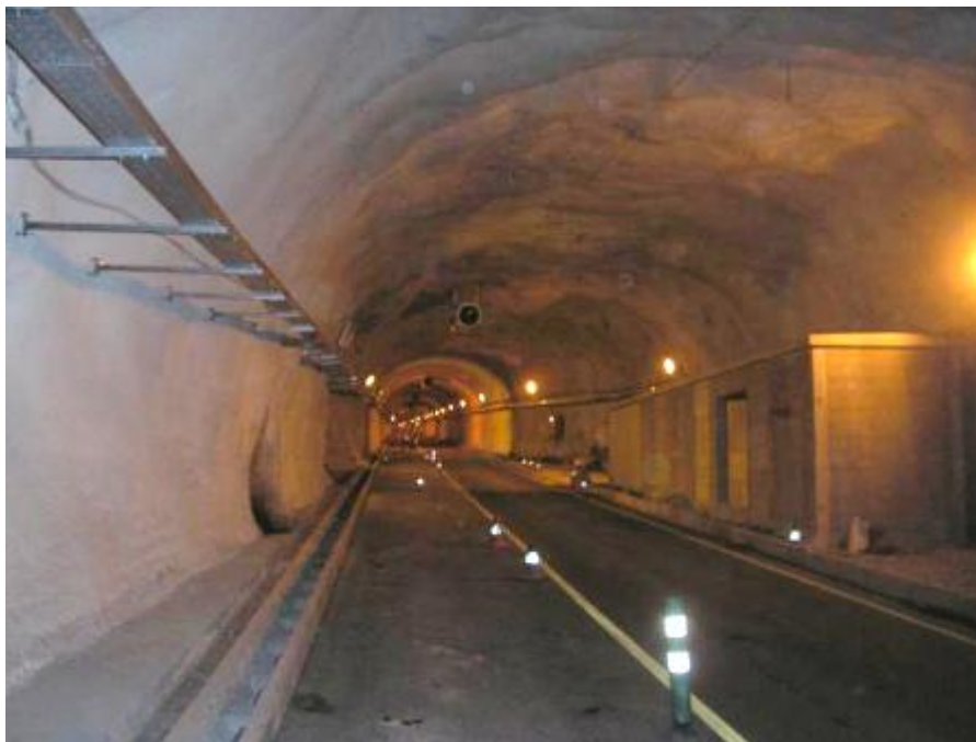
Imagen 6 : Zona de estacionamiento en medio del túnel
