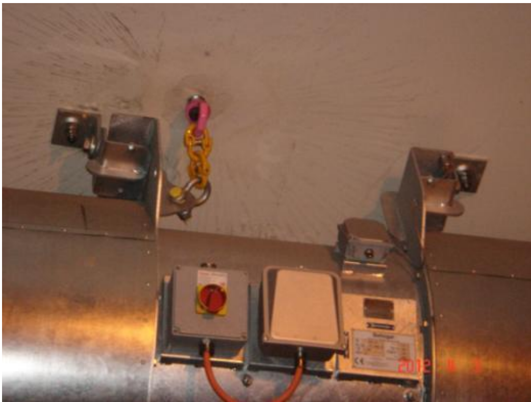
Imagen 37 : anclaje de los aceleradores en el arco.
