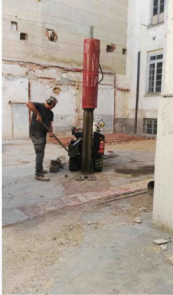
Penetración Dinámica N° 1, Emplazamiento.
