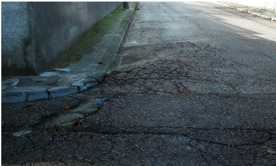
Ejemplo tomado en calle Pensamientos esquina con calle Geranios
