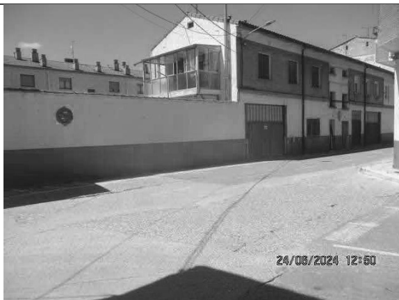
Vista final entronque sur sobre calle Calahorra
