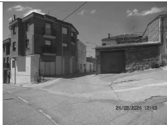
Vista cruce calle San Antonio
