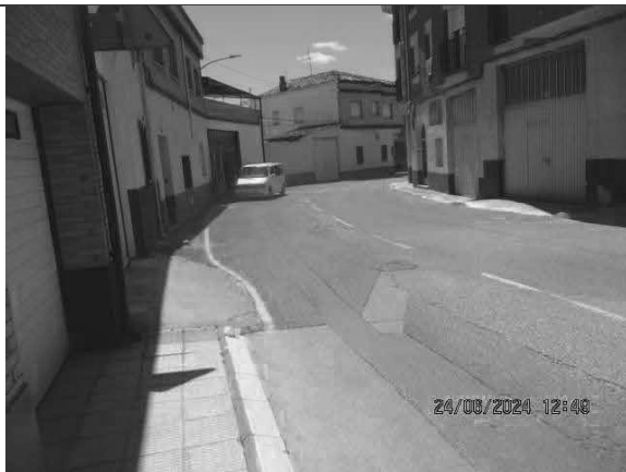
Vista ultimo tramo curva entronque calle Calahorra
