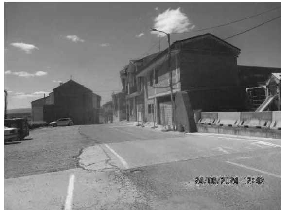
Zona de aparcamiento lindero hacia barranco
