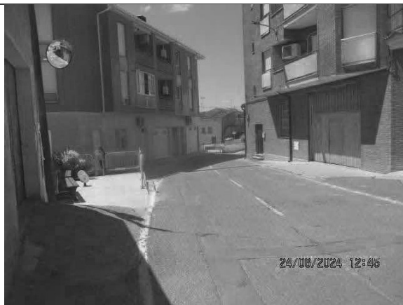
Vista bloque de pisos pasado cruce La Estrella
