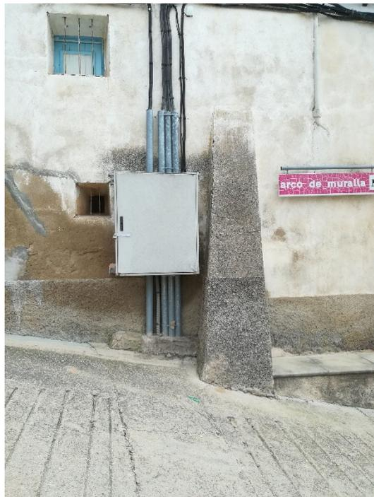
Se observa interiormente que se encuentra anticuado y además no cumple la normativa por lo que convendría realizar una renovación de este, añadiendo protecciones contra sobre intensidades transitorias y permanentes y además añadir interruptores diferenciales para la protección de contactos
