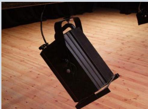
**14 pc's de 1000** (halógeno de cuarzo de 1000 w, foco ajustable, lente plano-convexa), de ellos 4 están ubicados en el corte frontal del techo del patio de butacas.
