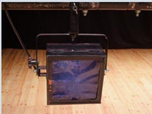
**5 cuarzos de 500** (halógeno de cuarzo lineal de 500 w, proyector panorámico asimétrico).
