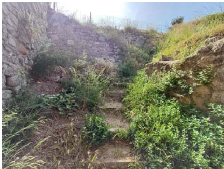
FOTO 2: Vista de la rampa escalonada desde la puerta de acceso.
