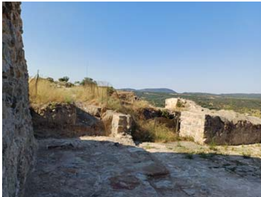
FOTO 8: Vista del encuentro de la rampa de acceso con la plataforma superior del castillo
