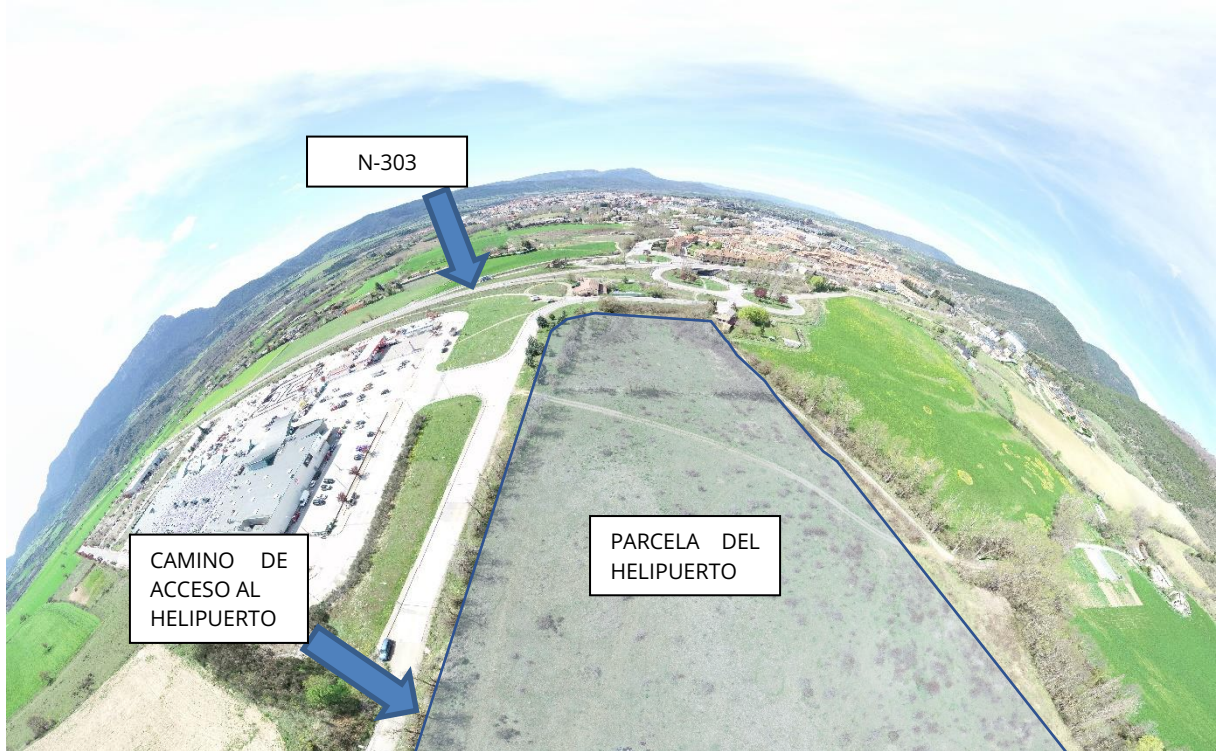
Figura 7. Acceso al helipuerto
