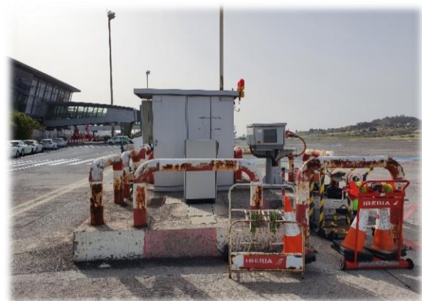
Imagen 3-4.- Instalaciones en plataforma. SVGA (izquierda) y Suministro 400 Hz (derecha)
