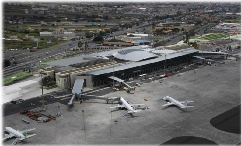
Imagen 3-2.- Imagen aérea de la zona de actuación
