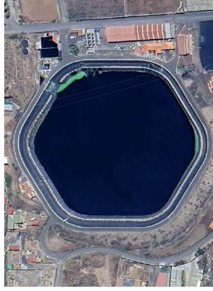
Ilustración 2. Estado actual de la balsa de Valle San Lorenzo.
