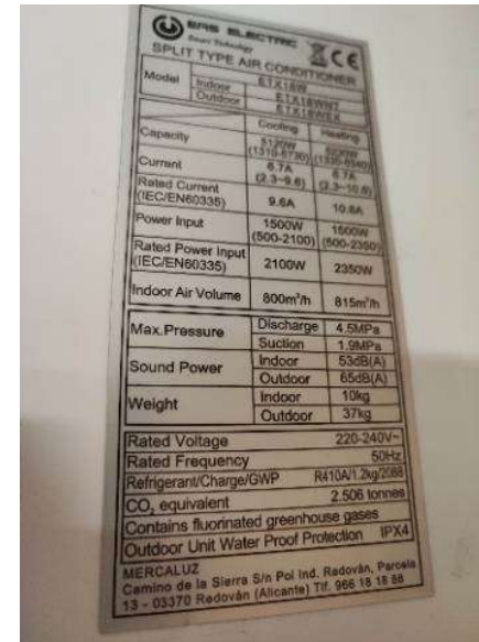
Ilustración 7 Placa de característica técnica autónomo Ers Electric
