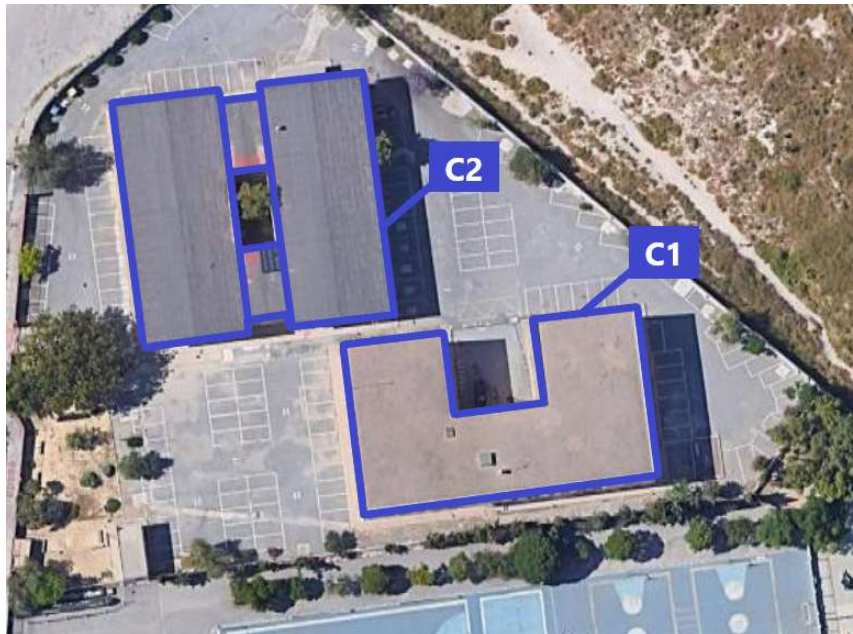
Ilustración 41 Identificación de la cubierta.
