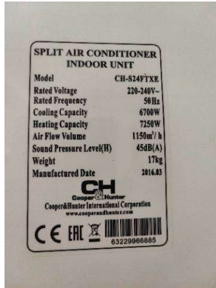
Ilustración 6 Placa de característica técnica autónomo Cooper & Hunter
