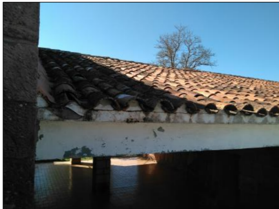
2 - SUSTITUCIÓN DE TEJA.
