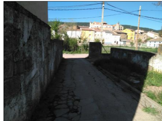
8 - SUSTITUCIÓN DE SOLADO DE HORMIGÓN
