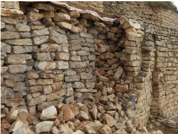
Fig. 5.- Gaviones estructurales (2011) e interior del resto del muro.
