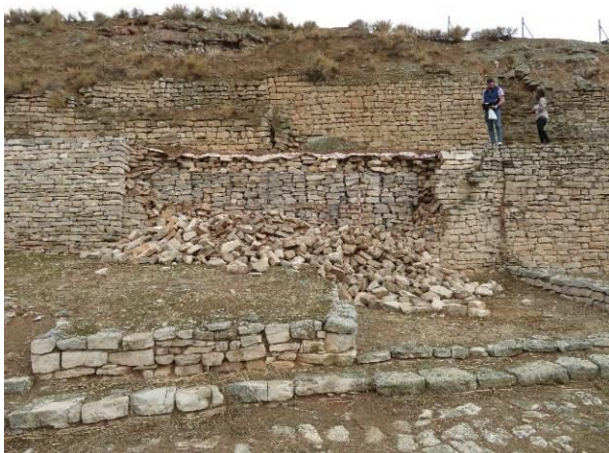
Fig. 2 y 3.- Zona del muro afectada por el hundimiento.
