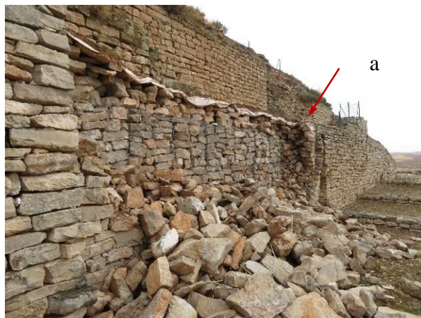
Fig. 2 y 3.- Zona del muro afectada por el hundimiento.
