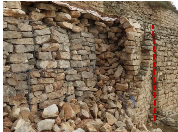
Fig. 6.- Junta vertical del muro.
