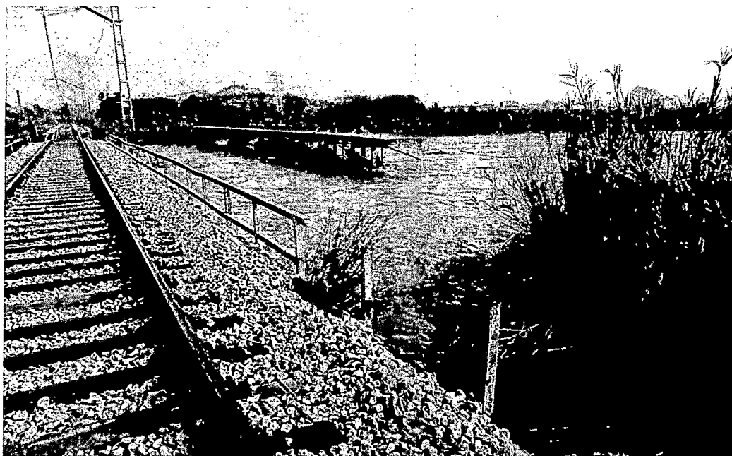
Figura 12. Imagen tomada el 23 de enero de 2020 por el personal de Adif en el estribo de entrada en sentido de kilometración ascendente.
