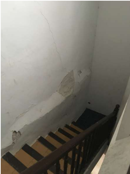
DETALLE ESCALERAS (foto cedida por el ayuntamiento de Logroño)
