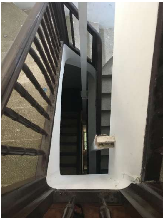
ESCALERAS CON REFUERZO (foto cedida por el ayuntamiento de Logroño)
