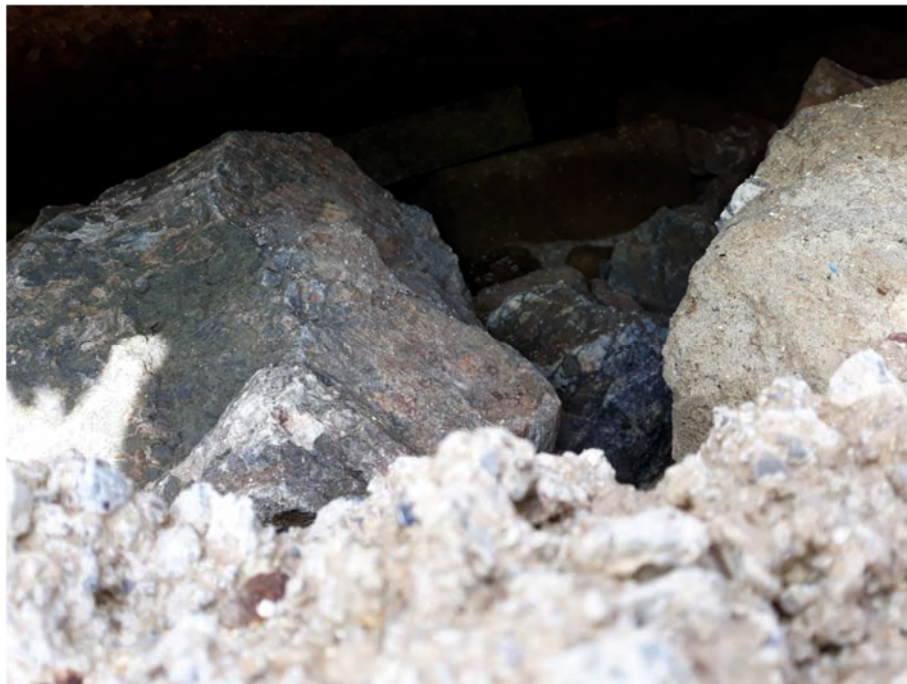
Detalle de la parte inferior de la losa
