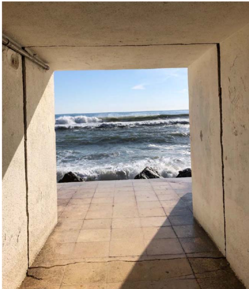
Estado paso inferior
