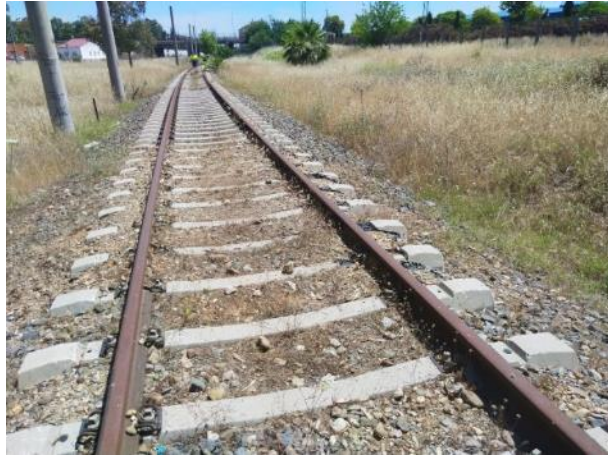
Imagen 53. Vegetación en la caja de vía
