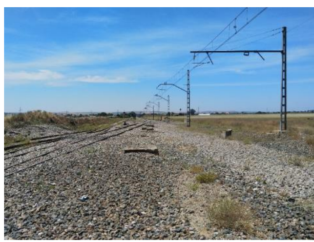
Imagen 44. Presencia de vegetación próxima a a la traza
