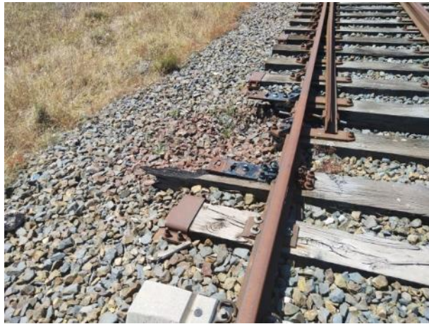
Imagen 54. Aparato tipo C del culatón próximo al cambiador sin timonería ni actuador
