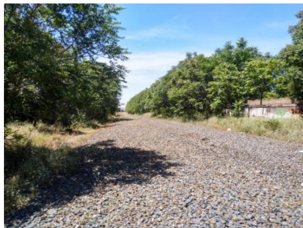
Imagen 43. Traza con presencia de balasto a retirar
