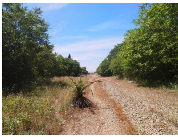
Imagen 43. Traza con presencia de balasto a retirar
