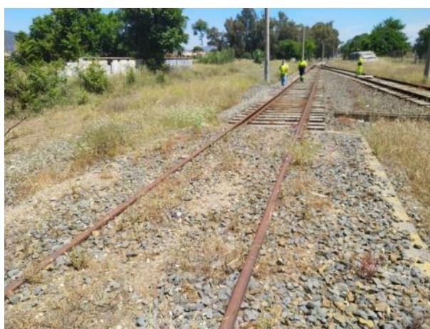
Imagen 18. Foso de descongelación del lado de la vía de ancho estándar
