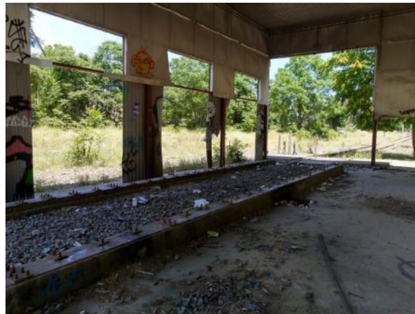
Imagen 15. Estado de nave del cambiador existente
