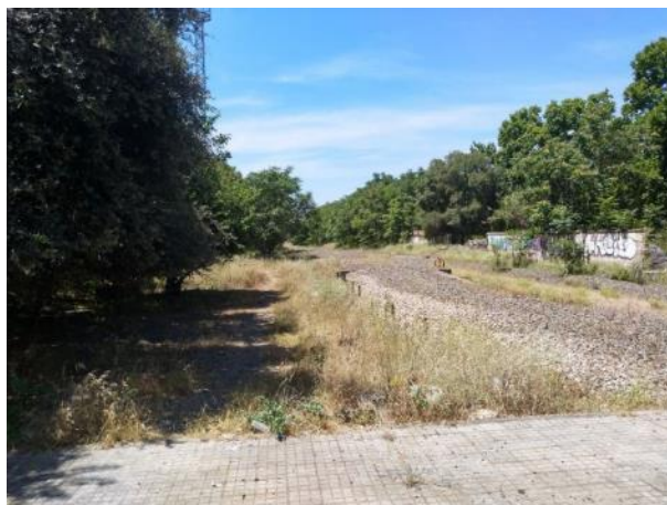
Imagen 17. Foso de descongelación del lado de la vía de ancho ibérico
