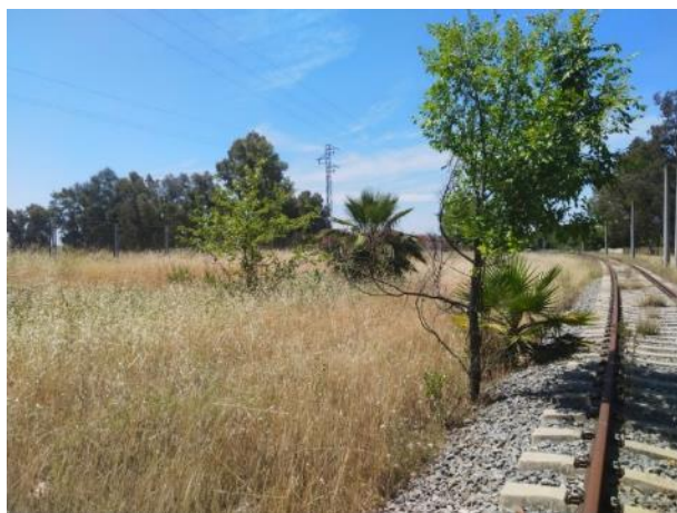
Imagen 20. Presencia de vegetación y árboles en la traza ferroviaria
