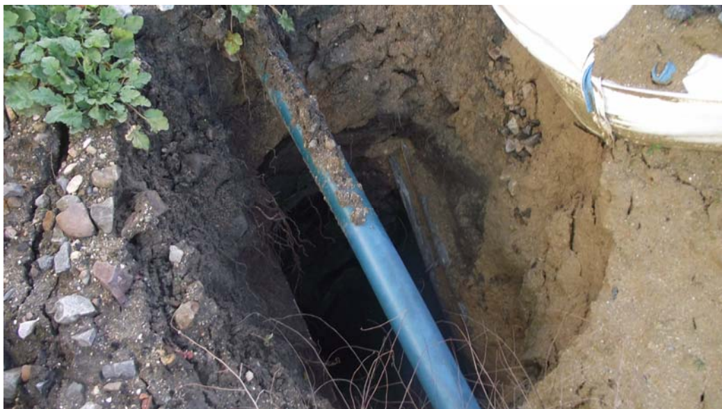
FOTO 1. Boca de socavón.
