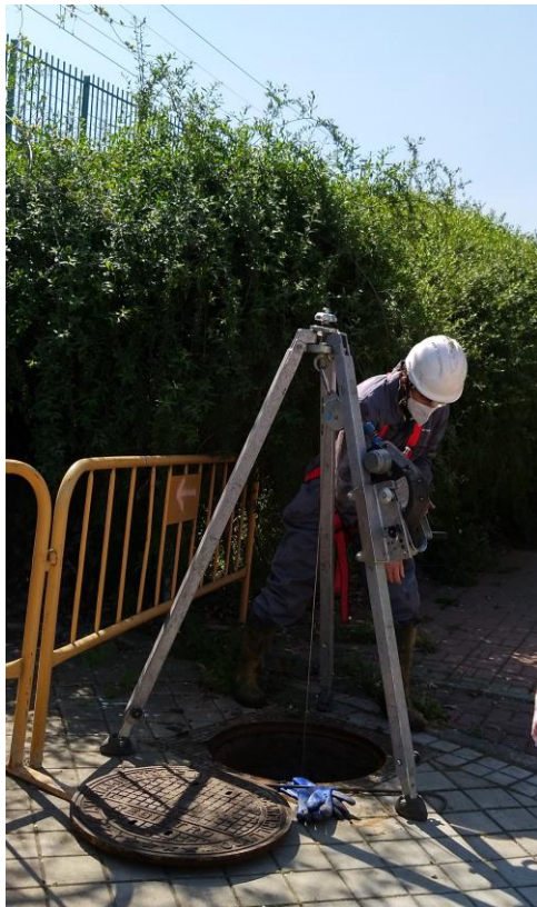
Registro del colector de saneamiento antes del cruce con la plataforma.
