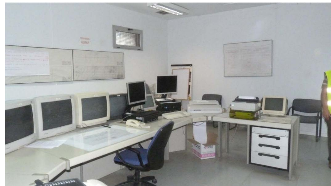
Ilustración 8 PLO de Majarabique dotado de tablero gráfico con buril y tres monitores videográficos antiguos.
