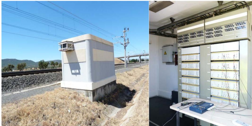
Ilustración 14 Casetas Nº 8 de circuitos vía, ubicada en 183+500, y vista interior de equipos interiores FTG-S.
