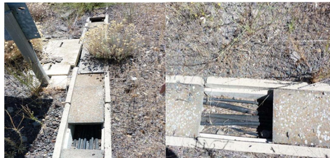
Ilustración 22 Canaleta prefabricada de hormigón con tapas rotas.
