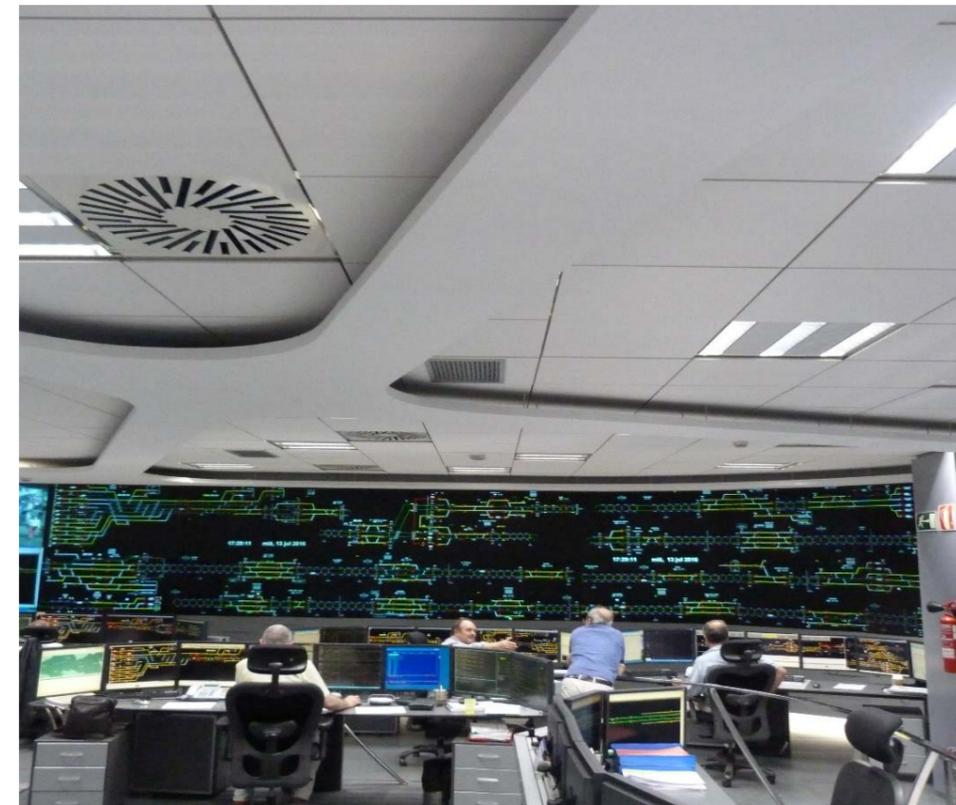
Ilustración 6 Puesto de Mando Central de CTC en la Sala de Control del CRC de Madrid-Puerta de Atocha.
