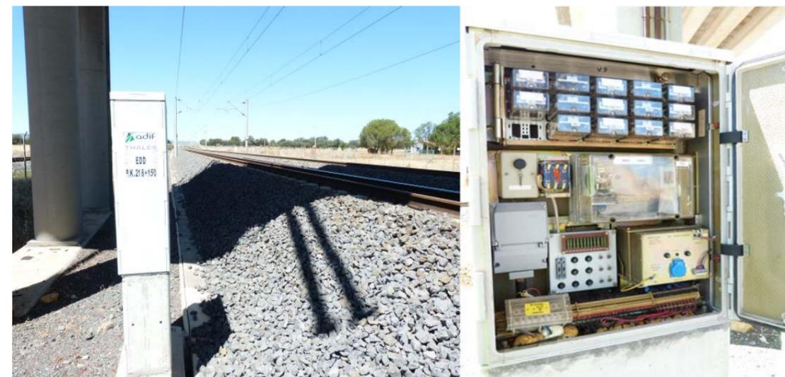
*Ilustración 21 Armario de vía del EDD instalado en el PK 218+150 y vista interior de su equipamiento.*
