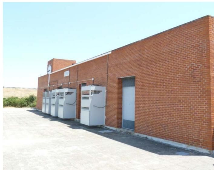
Ilustración 29 Equipos exteriores de tipo Mochila en el ET de Homachuelos.
