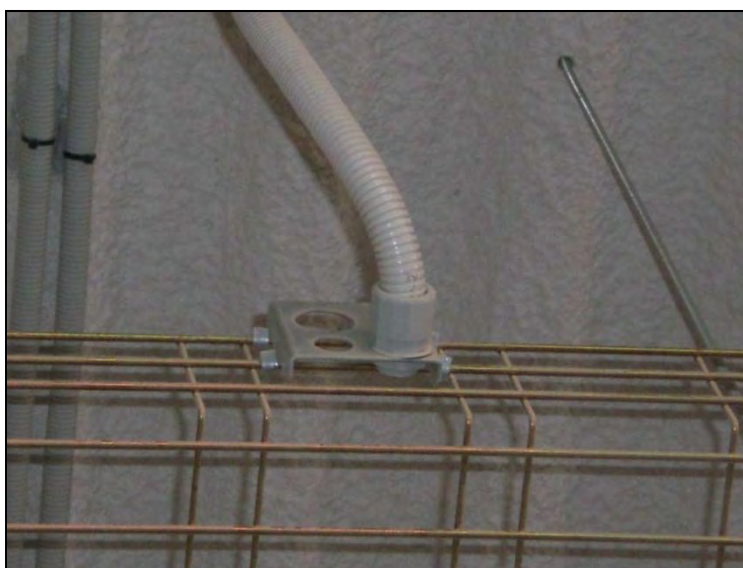
Figura 10. Detalle Pletina con Racor y Tubo visto desde exterior Bandeja REJIBAND.
