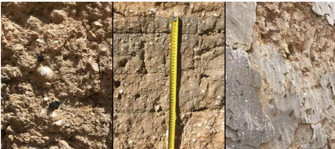
Figura 4. Izda; Aspecto de la masa del muro, Centro; Espesor de las tongadas, Dcha. Secuencia de varias capas de revestimiento en la zona interior del muro.
