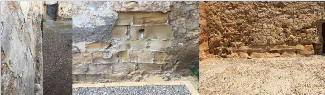
Figura 1. Izda; Muro visto desde arriba donde se aprecia el cambio de espesor, Centro; Primer nivel de piedra hacia el exterior, Dcha; Ídem hacia el interior.
