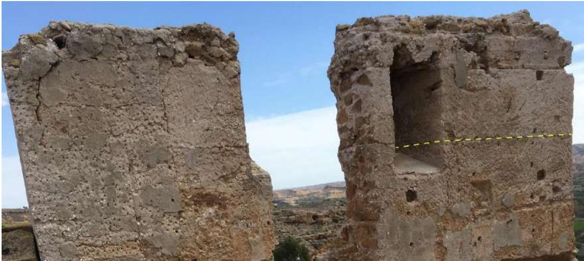
Figura 5. Saeteras conformadas de forma simultánea al muro.
