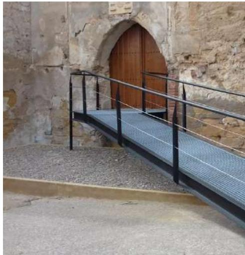
Figura izda. Vista del acceso tapiado . Figura dcha. Apertura del acceso sin actuar sobre el muro. Vistas desde el exterior del castillo, fachada Noreste.
