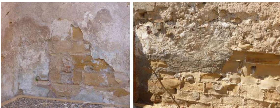
Figura 11. Presencia de eflorescencias y restos de cemento portland en el zócalo de la fachada noreste.
