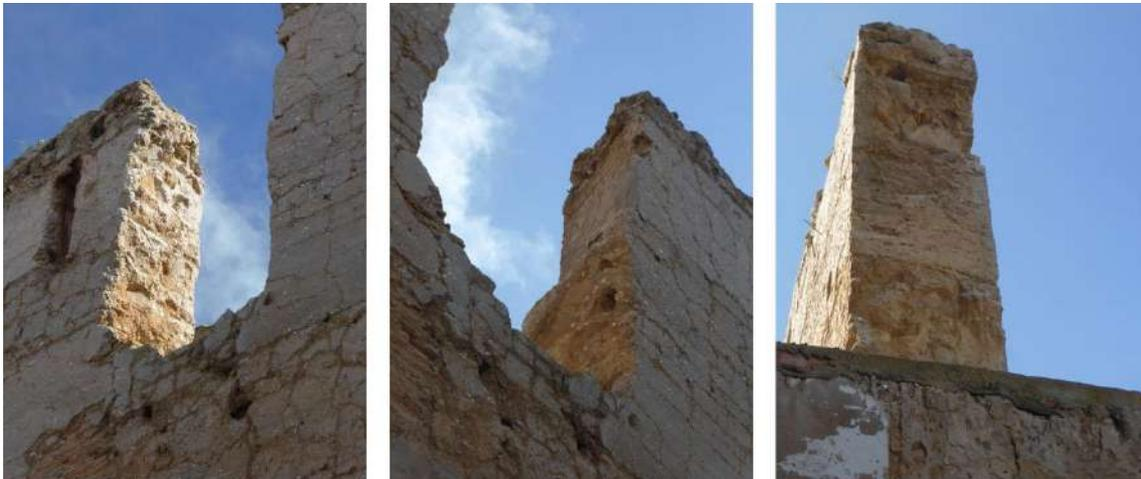
Figura 10. izda. y central. Deterioro del estado de conservación del muro en las jambas del hueco horadado de la parte superior. Figura dcha., lateral del muro con importante pérdida de masa.
