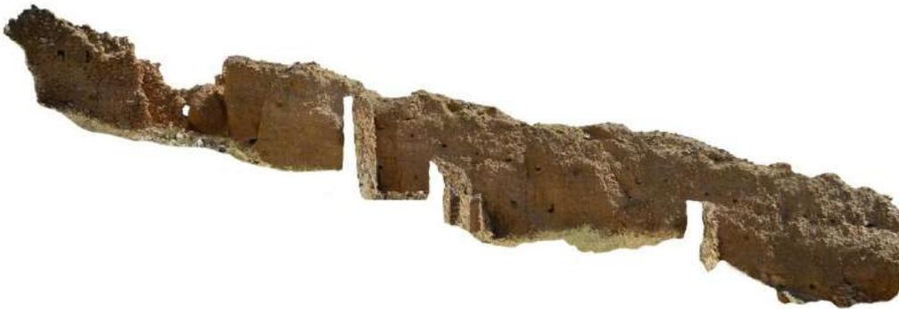
Figura 2. Muro de tapia en el cinturón de muralla de la localidad.
