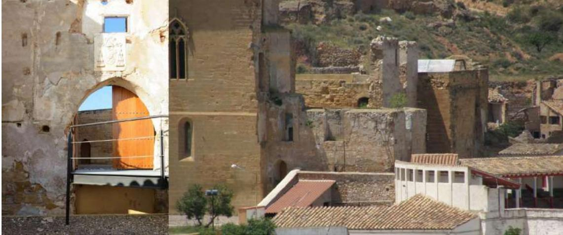
Figura 6. Izda; Acceso visto desde el exterior donde se aprecia la interrupción del zócalo de piedra. Dcha; Vista del muro sobresaliendo por encima de los restos de los torreones adyacentes.
