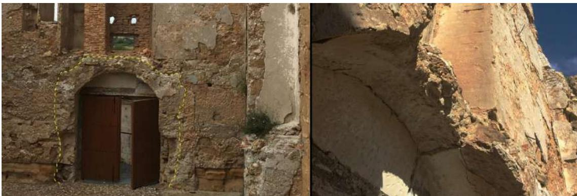
Figura 9. Izda; Ajuste del acceso actual al muro, Dcha. Arco encofrado con ajuste al muro.
