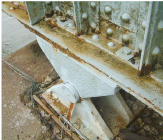
Imagen 8. Apoyo móvil en estribo Pravia. (IP 2004)
