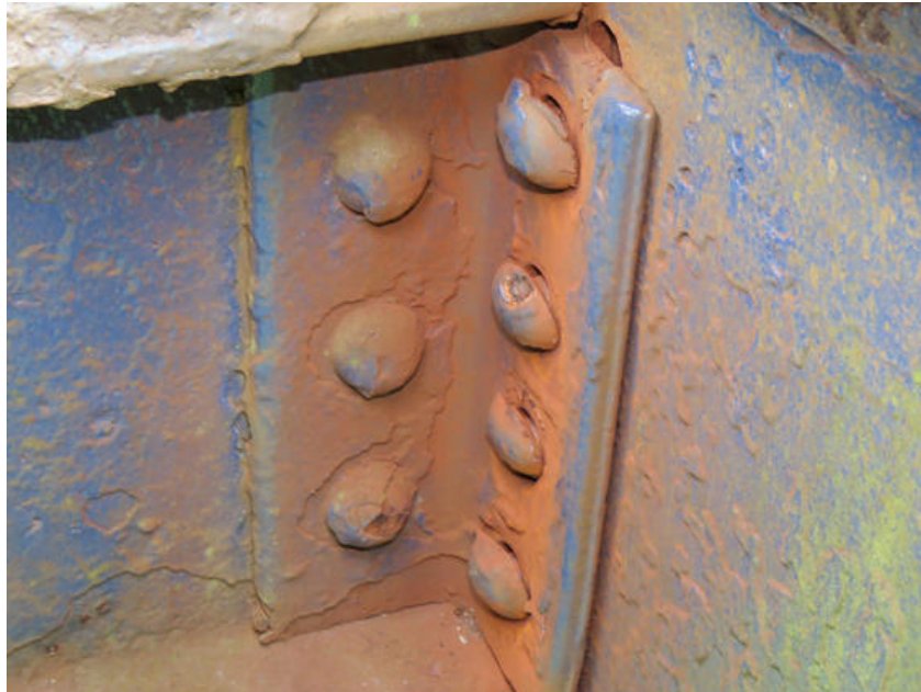
Imagen 21. Unión larguero 8º-vigueta 9ª suelta. (Estado actual)
