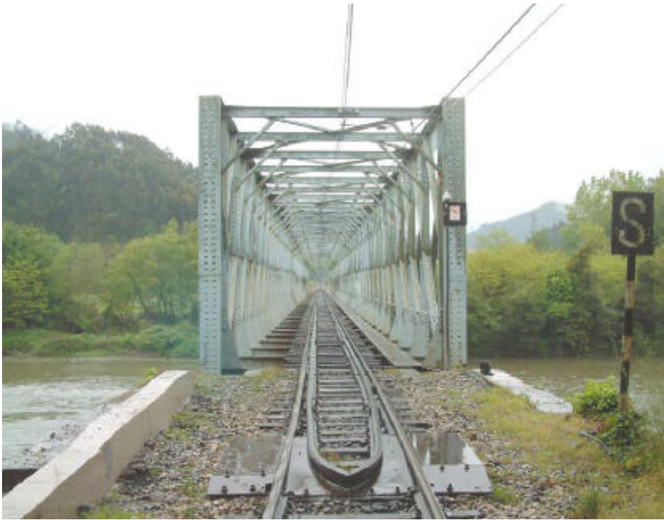
Imagen 4. Vista superior desde estribo Pravia. (IP 2004)
