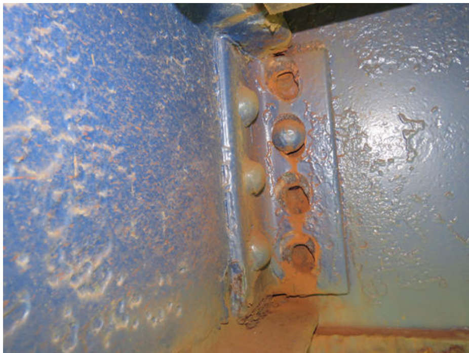
Imagen 22. Unión larguero 9º-vigueta 9ª suelta. (Estado actual)
