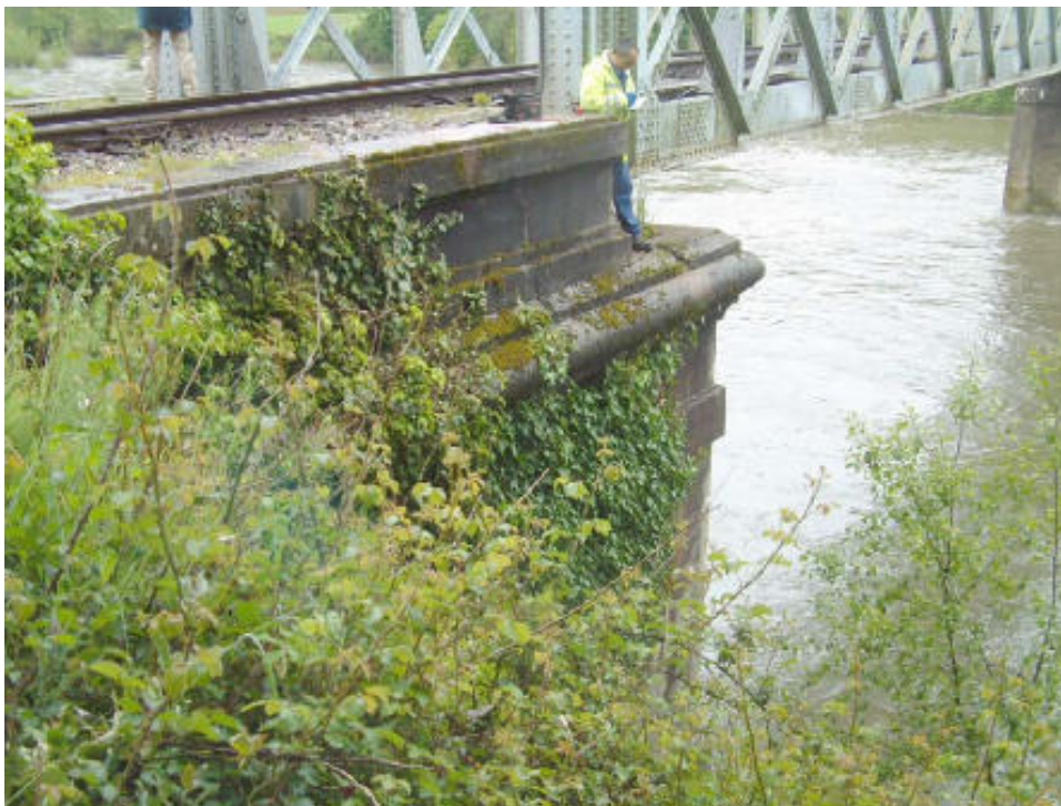
Imagen 5. Estribo lado Pravia. (IP 2004)
