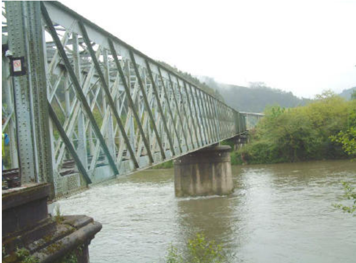
Imagen 3. Vista lateral desde estribo Pravia. (IP 2004)
