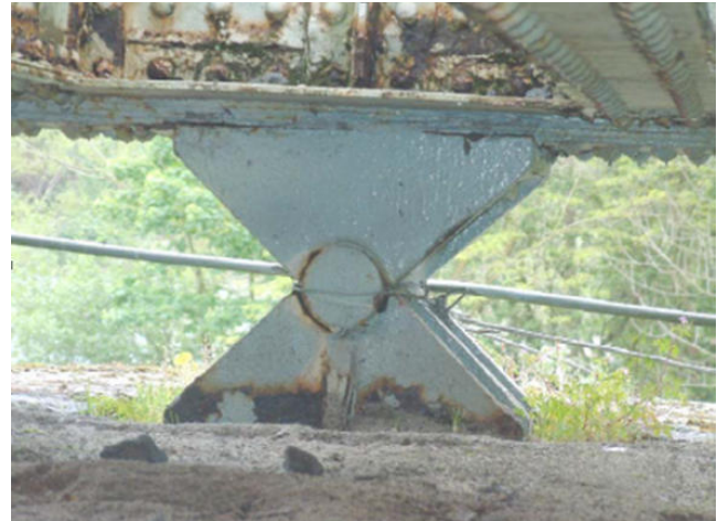
Imagen 9. Apoyo fijo en pila 2. (IP 2004)
