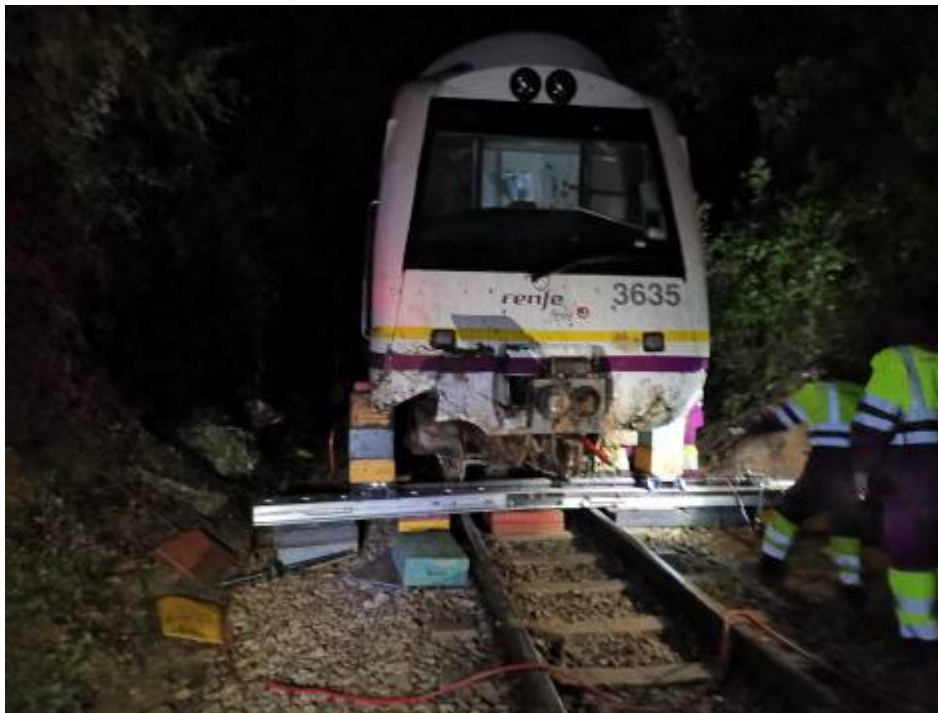
Labores de encarrilado del vehículo accidentado.
