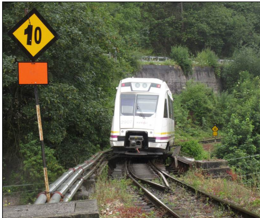
Imagen 4. Vista general desde estribo lado Mieres de la L764
