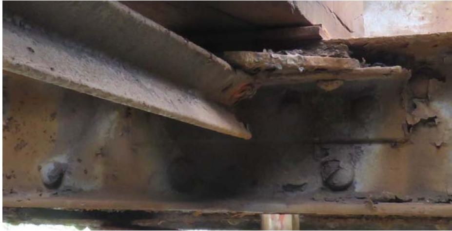
Imagen 25. Contralazo suelto de la cartela de unión al largoero
