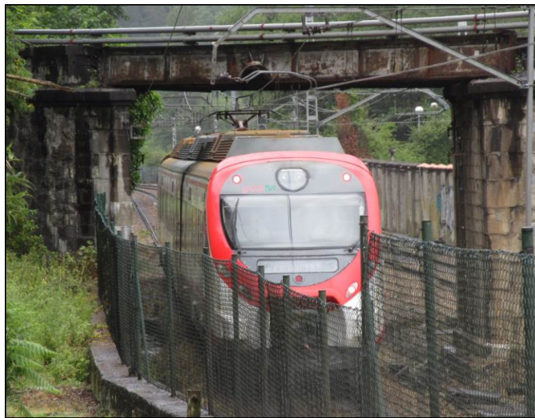
Imagen 35. Comprometida situación de la catenaria de la línea 130 y el tablero metálico de la línea 764
