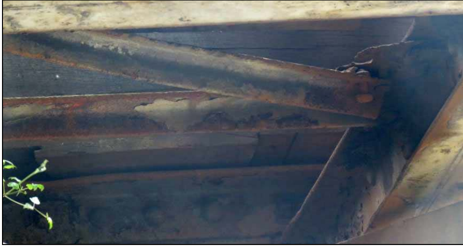
Imagen 24. Contralazo desprendido de la cartela de unión al largoero
