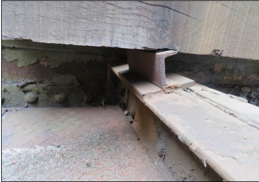
Imagen 18. Deformación de ala superior de larguero
