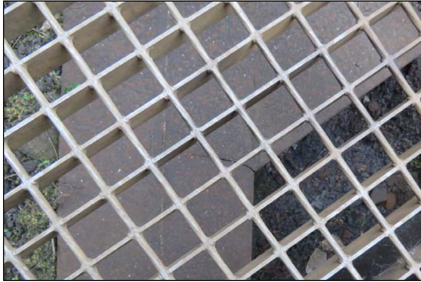
Imagen 20. Fisura en vigueta de borde
