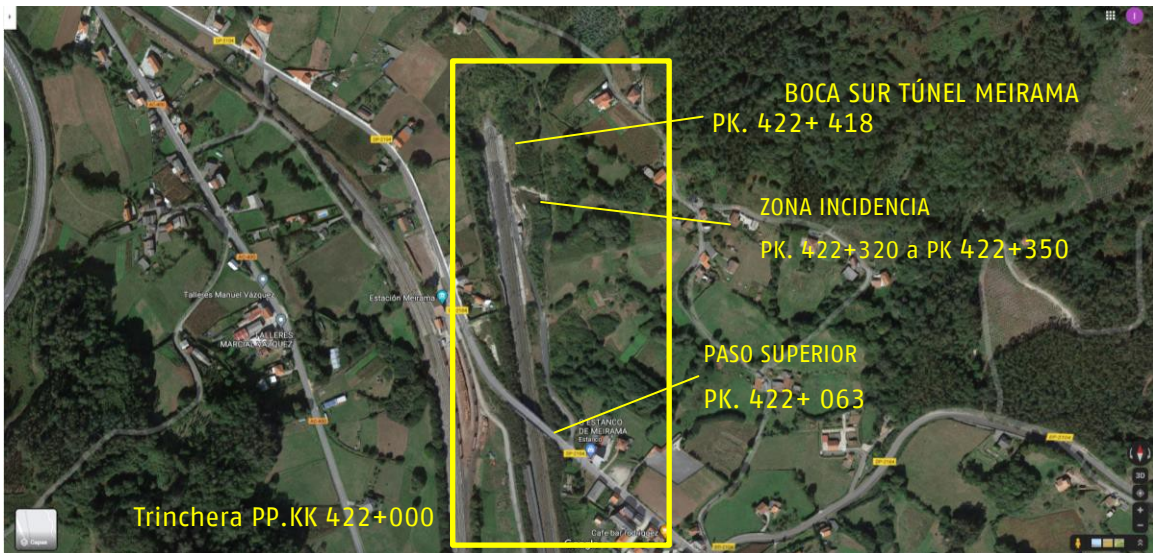
Fotografía aérea de la zona afectada.
